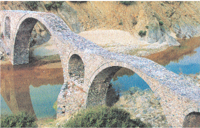
Το πέτρινο γεφύρι του ποταμού Κομφάτου.
